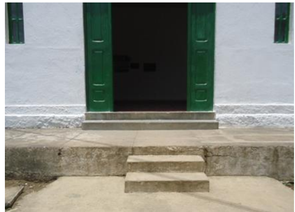
Figura 55.2- Degraus na entrada
