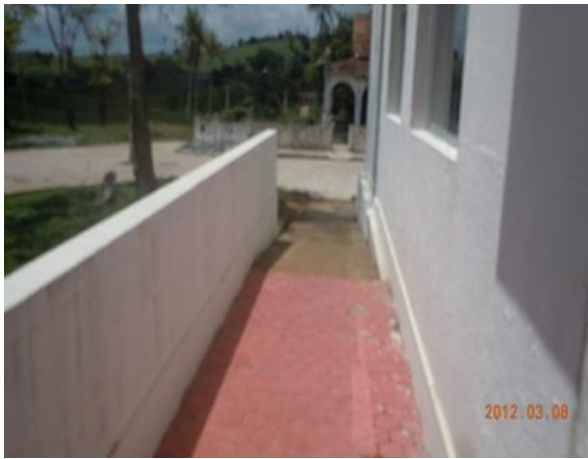
Figura 56.5 - rampa vista de cima
