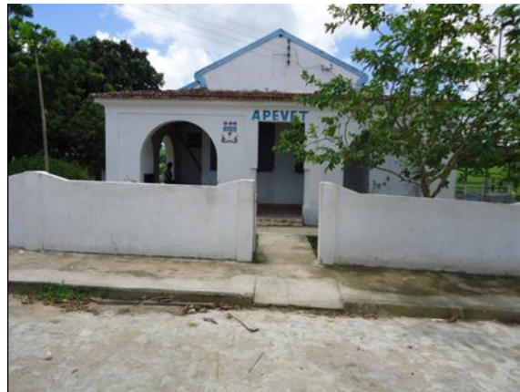
Figura 56.7 - fachada do ambulatório
