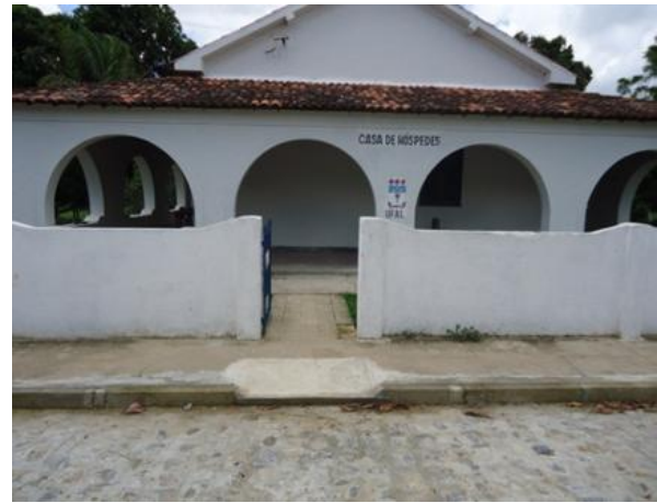
Figura 56.6 - fachada casa de hóspedes
