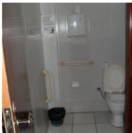
Figura 62.15 - Banheiro acessível e adequado em todos os pavimentos do bloco anexo.
