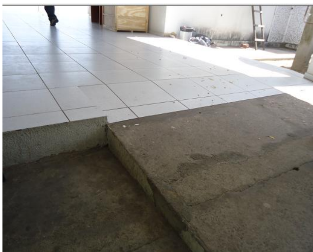
Figura 59.1 –Detalhe - rampa para Pedestres Após a Entrada, sem corrimão. Figura 59.2 – Rampa para pessoas com deficiência após o Pátio Central - acessível, mas sem sinalização.
