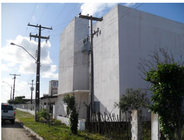
Figura 15 – Vista externa do bloco em anexo a Unidade Penedo, com 3 pavimentos, onde se localizam salas de aula e laboratórios.
