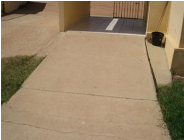
Figura 43.3 - Rampa de acesso de pedestres.
