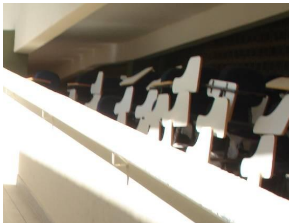
Figura 55 - Cadeiras depositadas sob a rampa de acesso ao segundo pavimento.
