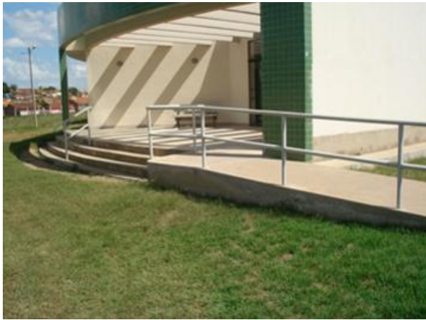
Figura 43.7 e 43.8 - Acesso de pedestres – corrimão inadequado, e não há pavimentação abaixo da escada, portanto está inadequada.
