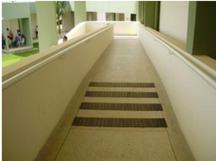
Figura 44.19 e 44.20 - Piso tátil direcional e de alerta em material plástico, colado no piso definitivo da rampa ao pavimento superior.
