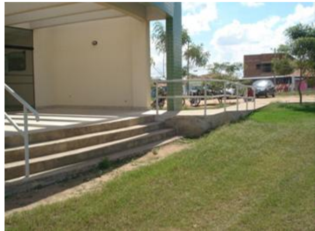
Figura 43.7 e 43.8 - Acesso de pedestres – corrimão inadequado, e não há pavimentação abaixo da escada, portanto está inadequada.
