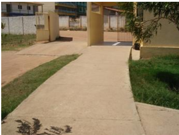
Figura 43.5 e 43.6 - Circulação entre estacionamento e passarela para pedestres – não há pavimentação entre elas.
