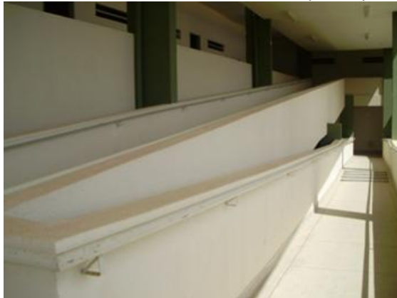
Figura 44.21 - Corrimão inadequado na rampa de acesso ao pavimento superior. Figura 44.22: Escada sem corrimão.
