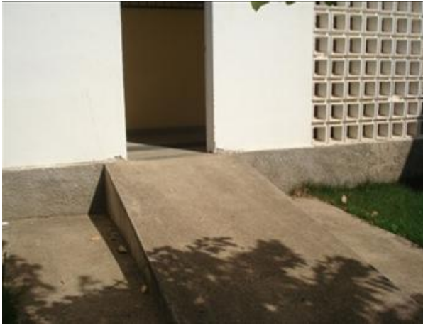
Figuras 45.29 e 45.30 - Acesso ao jardim interno – rampa muito inclinada e sem corrimão, e vegetação localizada no meio do percurso.
