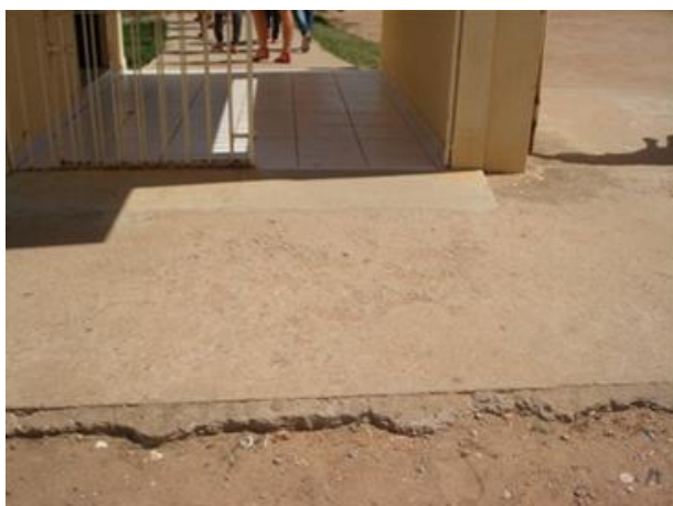
Figura 43.1- Obstrução em calçada, no acesso. Figura 43.2: Desnível no acesso a unidade.
