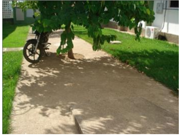
Figuras 45.29 e 45.30 - Acesso ao jardim interno – rampa muito inclinada e sem corrimão, e vegetação localizada no meio do percurso.
