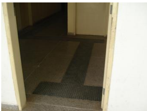
Figuras 45.27 e 45.28 - Piso tátil direcional e de alerta em material plástico, colado no piso definitivo dentro do setor administrativo, local de grande fluxo de pessoas e desgaste do piso.
