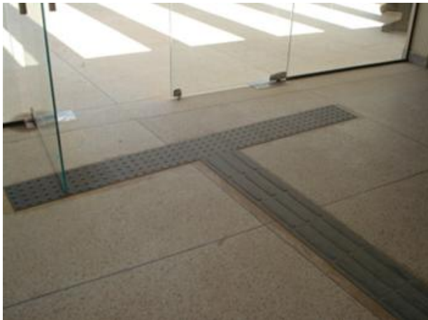
Figura 43.10 e 43.11 - Piso tátil direcional e de alerta em material plástico, colado no piso definitivo. O desgaste do material plástico pode causar acidentes.
