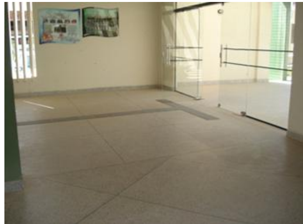
Figura 43.10 e 43.11 - Piso tátil direcional e de alerta em material plástico, colado no piso definitivo. O desgaste do material plástico pode causar acidentes.
