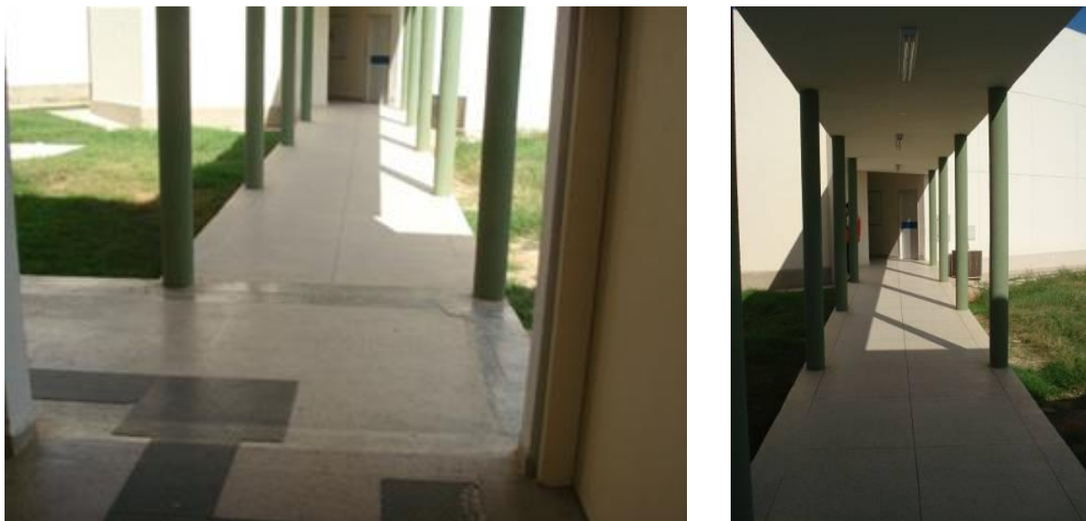
Figuras 45.35 e 45.36: Rampas e acesso ao bloco da biblioteca e dos laboratórios.
