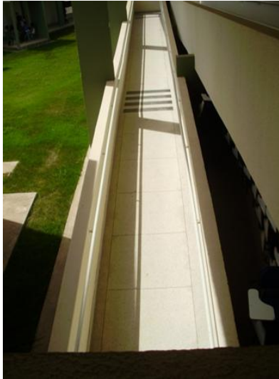
Figura 44.19 e 44.20 - Piso tátil direcional e de alerta em material plástico, colado no piso definitivo da rampa ao pavimento superior.
