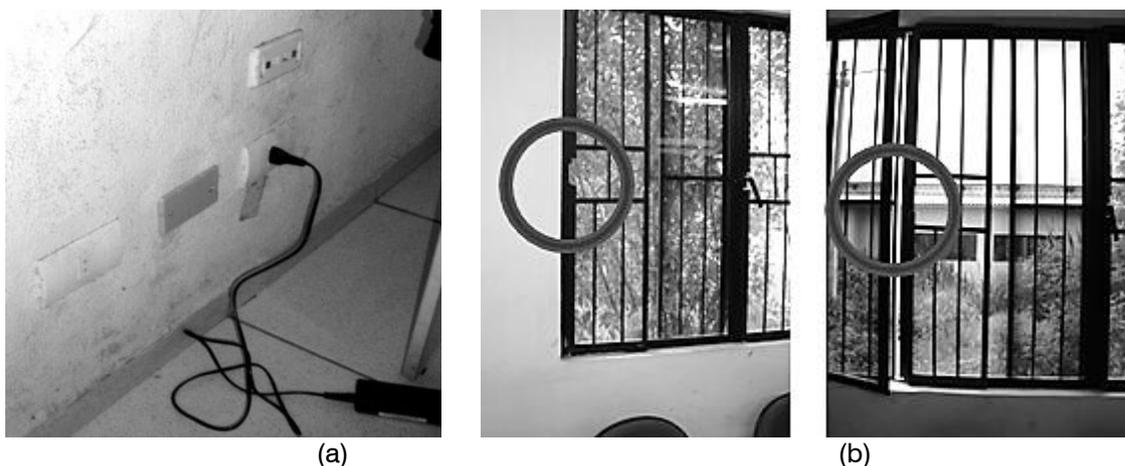
Figura 62 – (a) Instalações elétricas insuficientes para o uso dos estudantes, único ponto de energia encontra-se abaixo do quadro branco (lousa), e (b) Esquadrias com travas e maçanetas danificadas, dificultando seu uso.
